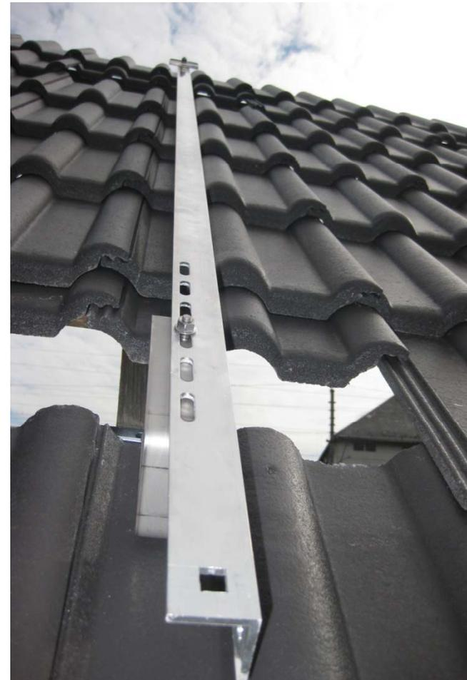
Klemmbacken greifen auf der PRS Montageschiene oder können direkt auf den Kollektor geklemmt werden. (Weglassen der Montageschienen)
